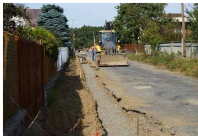
Po několika desetiletích se i Zahradní ulice dočká nových povrchů a veřejného osvětlení.
