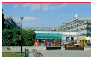
zateplení školy V. Havla
