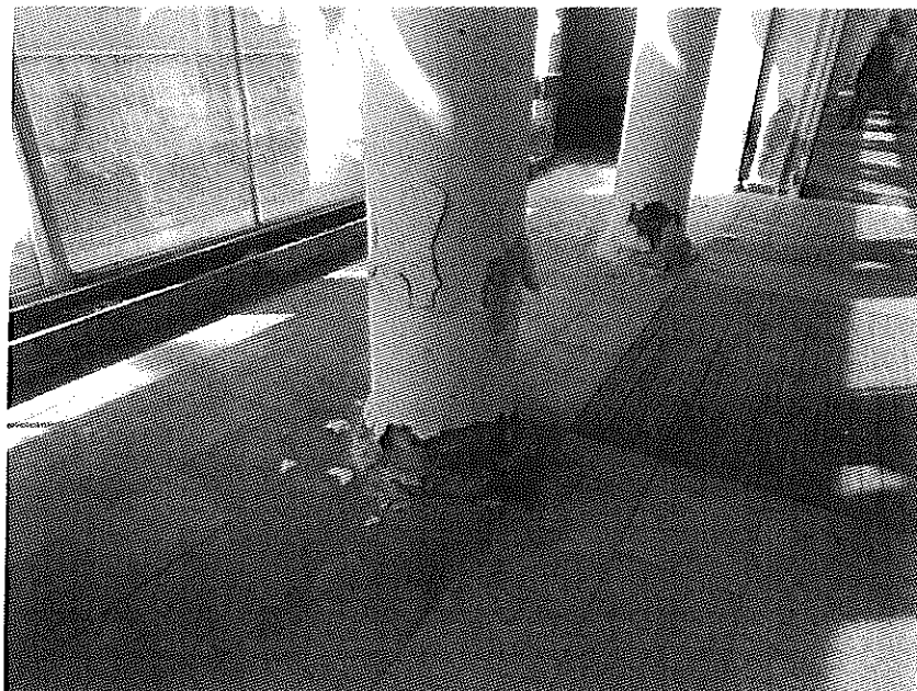
Obr. 2: Podmáčení sloupu, krystalizační expanze
