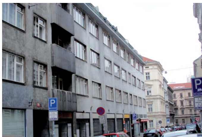
Příčná 1-3 před rekonstrukcí...
