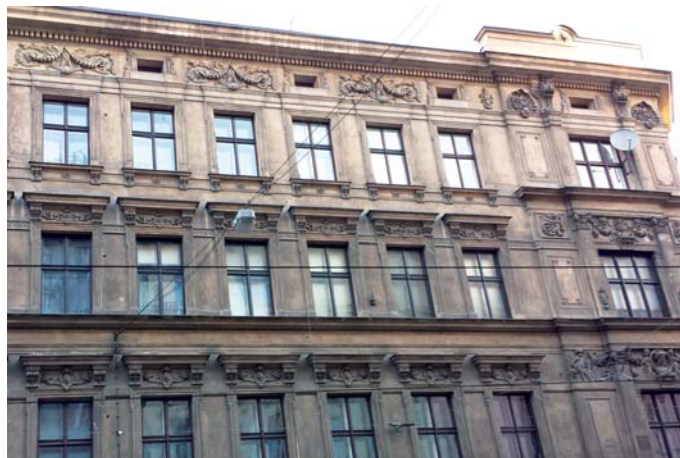
Dušní 4 před rekonstrukcí...
