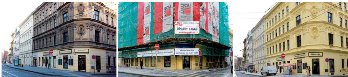
Černá 2 před rekonstrukcí...
