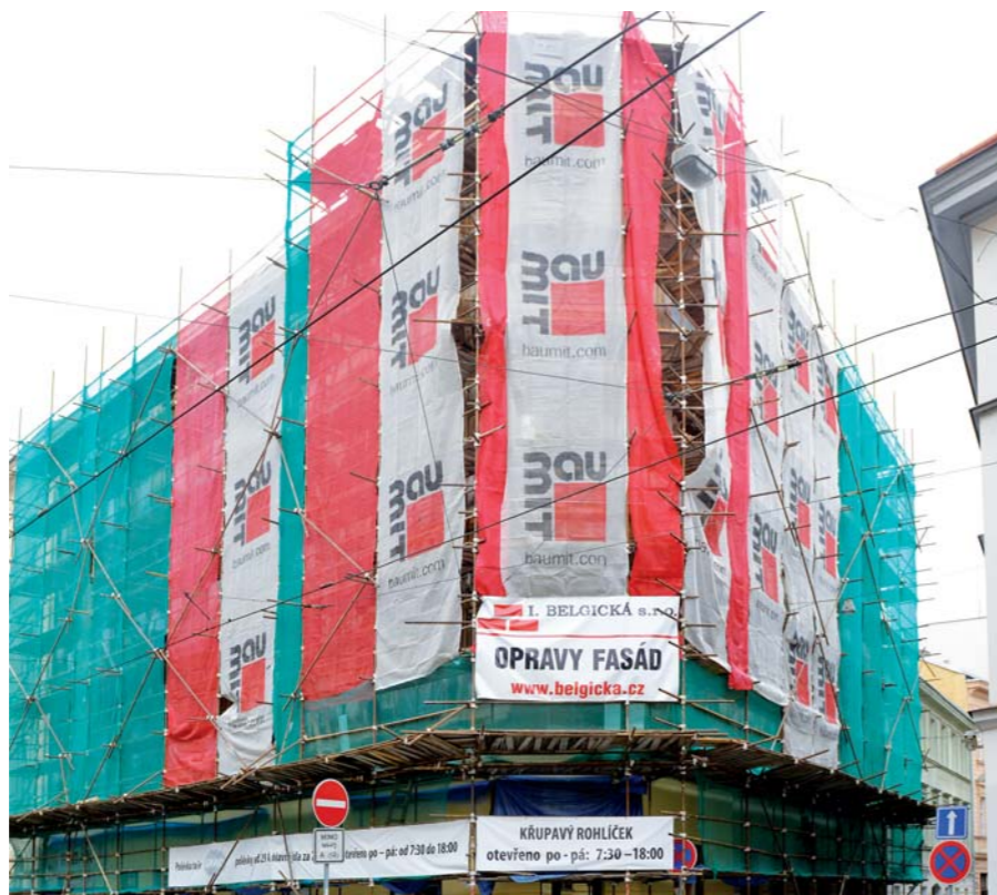
Díky grantu jsou opravovány také fasády.
