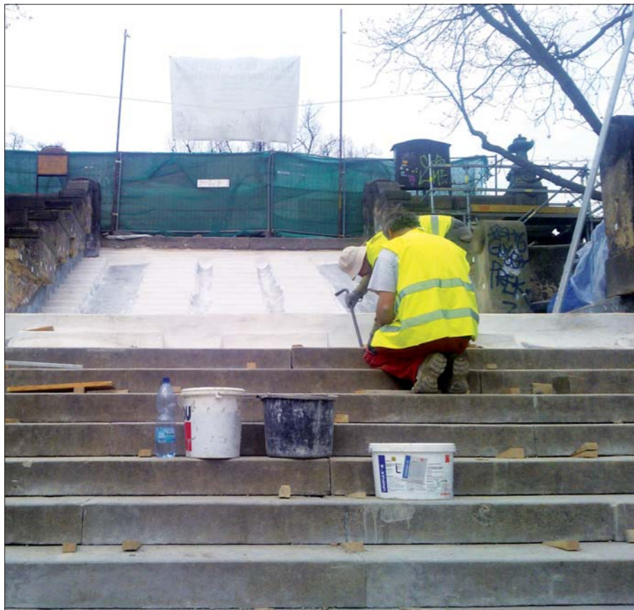
Rekonstrukce se samozřejmě dočkal i samotný vstup na ostrov.
